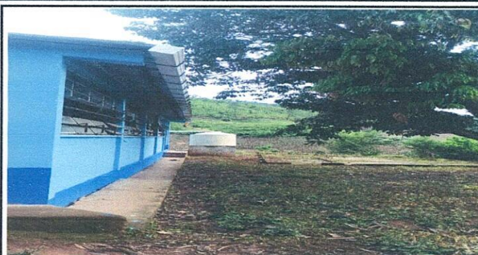
Foto 2: ESTADO ACTUAL DE FINALIZACIÓN DE PINTURA DE PAREDES
