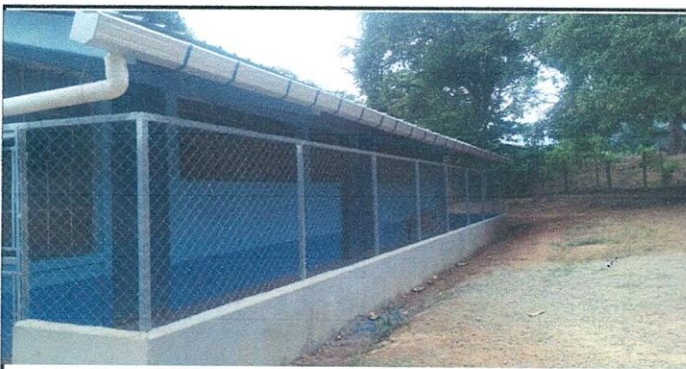
Foto 5: ESTADO ACTUAL DEL CANAL
